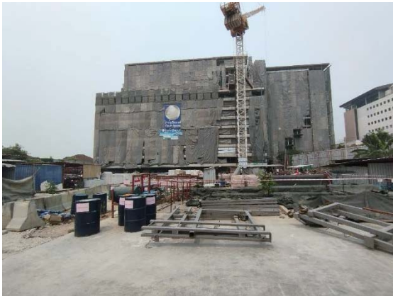
รูปที่ 7 การปิดกั้นตัวอาคาร และแผนป้องกันวัสดุตกหล่น
