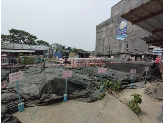
รูปที่ 7 การปิดกั้นตัวอาคาร และแผนป้องกันวัสดุตกหล่น
